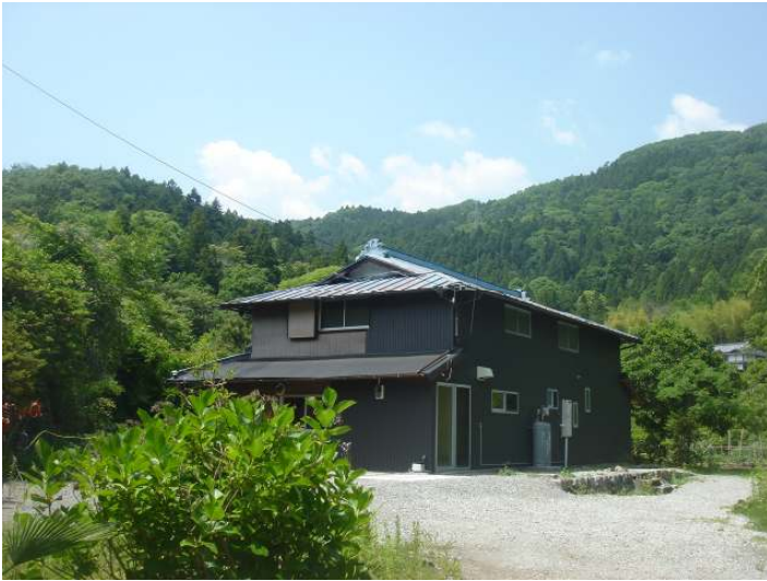
北側より敷地・建物全景
