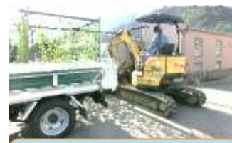
腐葉土等の撤去作業の様子
