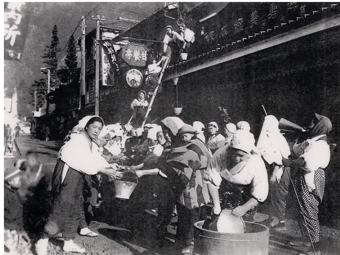
国防婦人会による防火訓練(身延 上町・橋町) 昭和13年 (画像提供: 甘養亭河喜)
