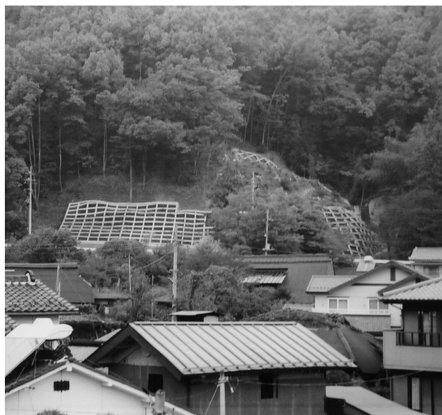
西嶋地内の治山工事
