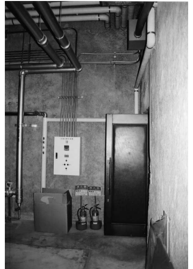
アスベスト調査中の 役場ボイラー室
