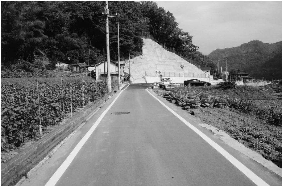
改修が進む県道遅沢静川線
