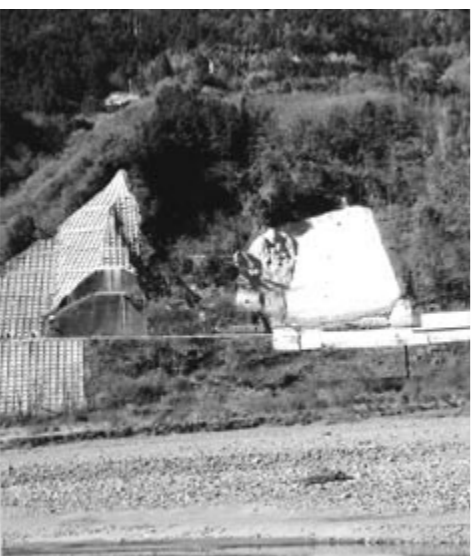
早期完成が待たれる古屋敷防災工事
