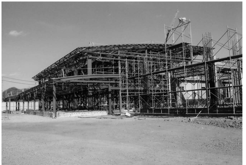
建設中の北小学校
