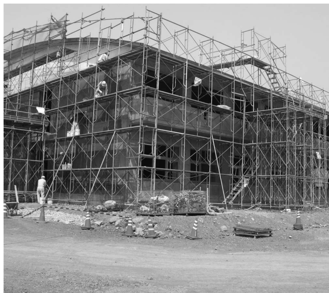
北小学校建設現場
