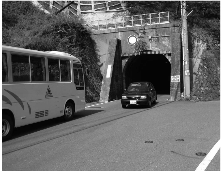
現在の照坂トンネル
