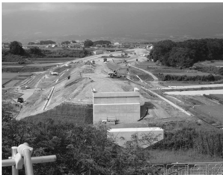
佐久工事現場
