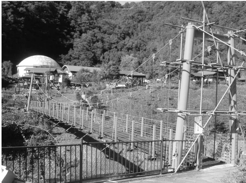
橋の塗装工事（農村文化公園）
