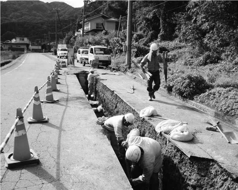
下水道工事(下田原地内)
