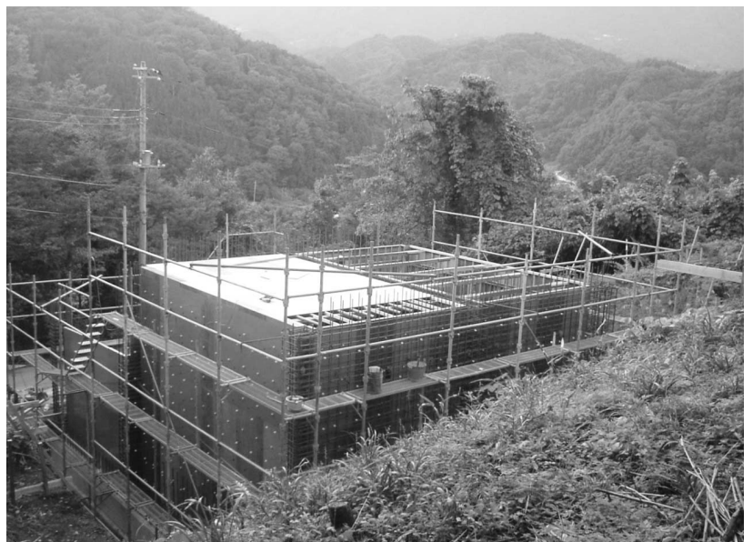
中富東部簡易水道配水池築造工事
