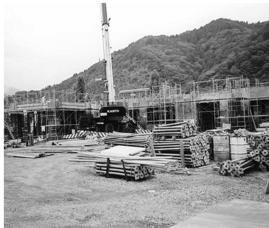
工事中の身延福祉センター
