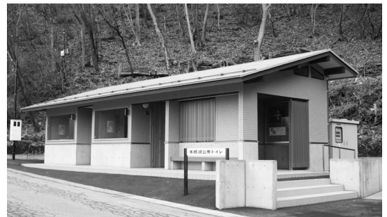
完成した本栖湖公衆トイレ
