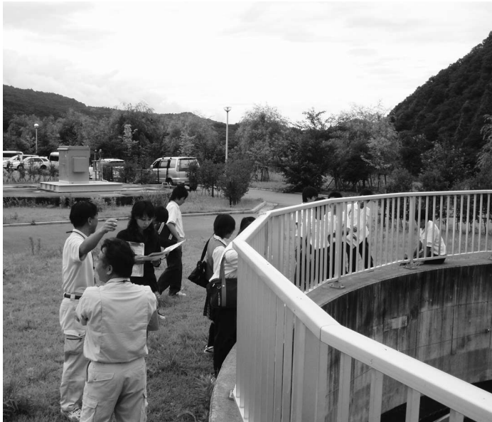
下水道終末処理場 (飯富地内)
