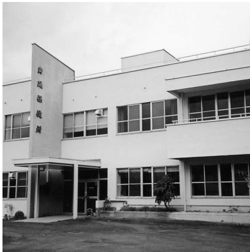
改修される旧身延保健所
