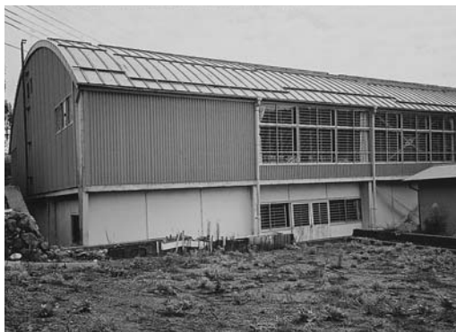
改修の予算が計上された西嶋小体育館
