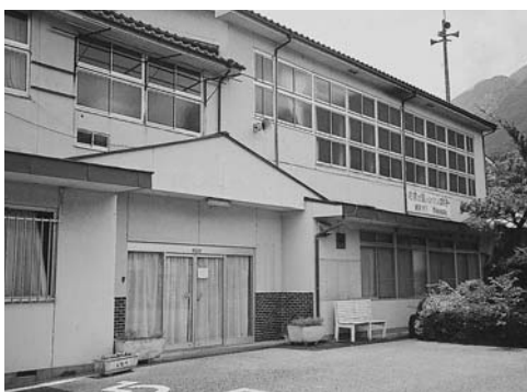
取り壊される旧下部支所
