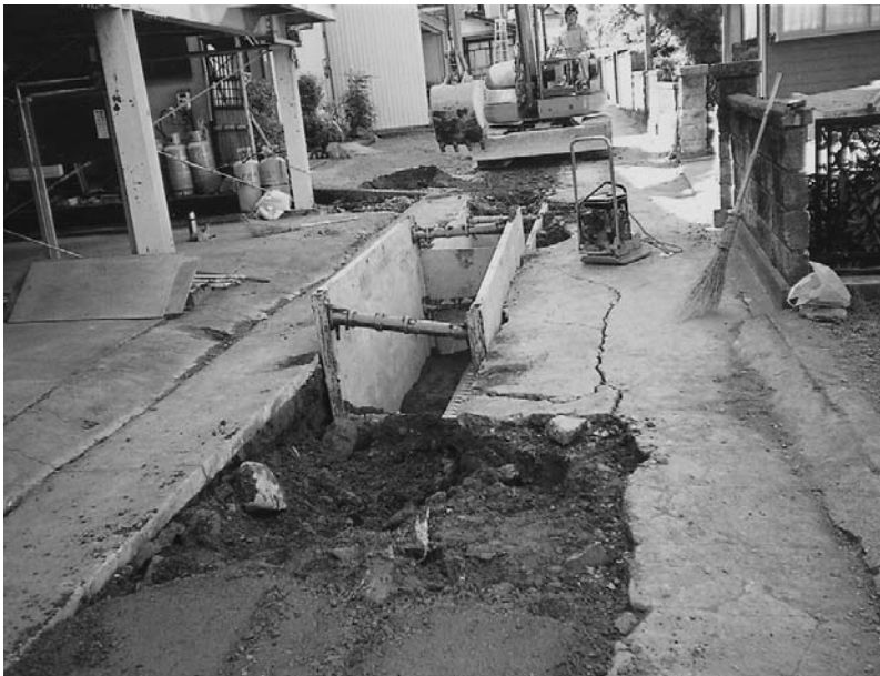
供用開始にむけ工事が進む下水道事業
