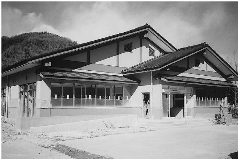
年度内完成をめざして工事が進む西嶋分館
