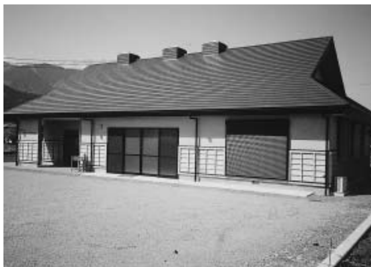
和田農作業準備休憩施設（中山間事業）
