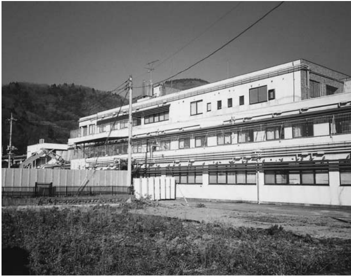
増改築工事が始まった飯富病院
