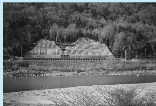
圧送管移設工事が行われる八日市場防災工事
