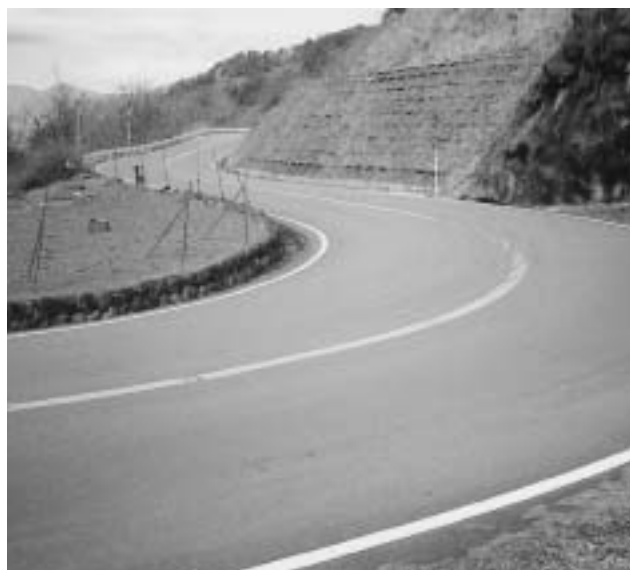
改修が決定した国道300号 中ノ倉集落・中ノ倉トンネル手前間
