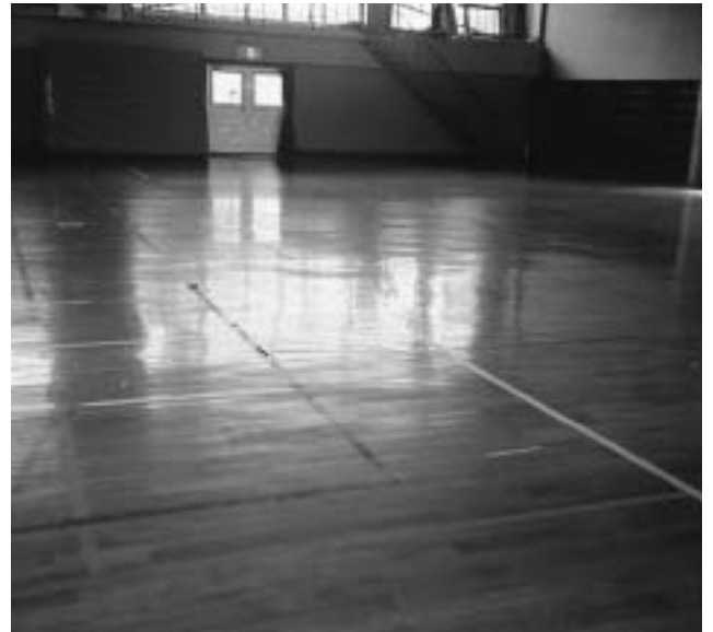
床等の改修予定の身延小学校体育館内
