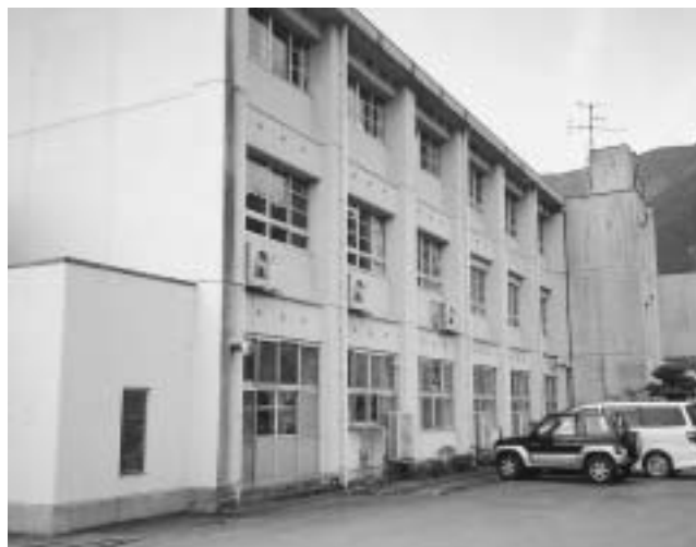
工事が始まる身延小学校大規模改造工事
