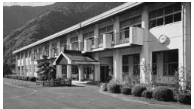
利活用が検討される旧豊岡小学校
