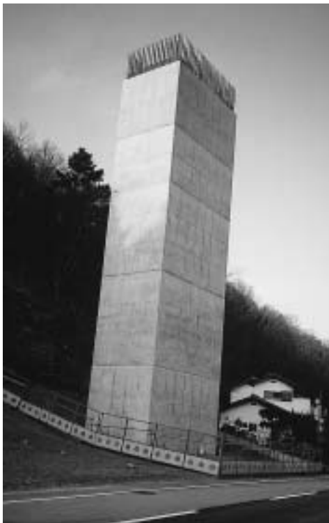
工事が進む中部横断自動車道 (下田原地内)
