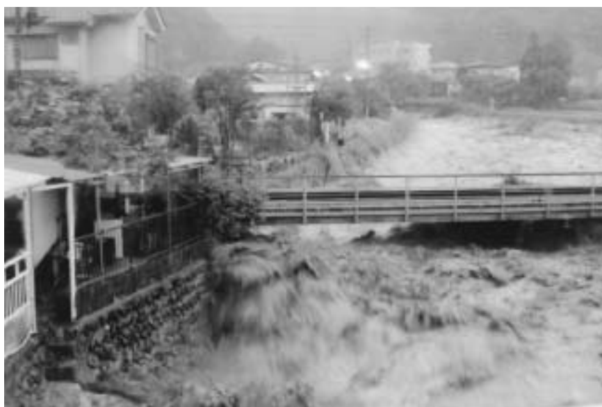
台風15号猛威「椿川増水の様子」9月21日（水）16：43撮影 JR身延線塩之沢駅付近
