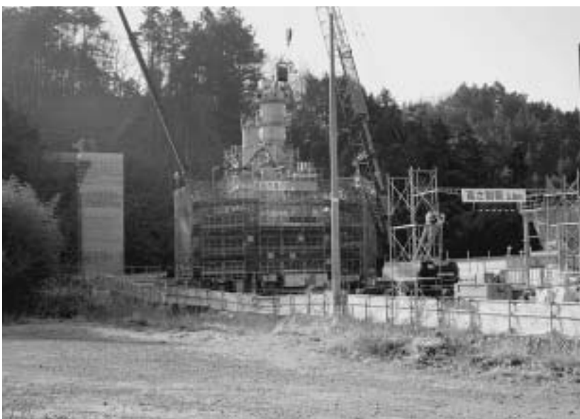
中部横断自動車道橋脚工事（下田原）
