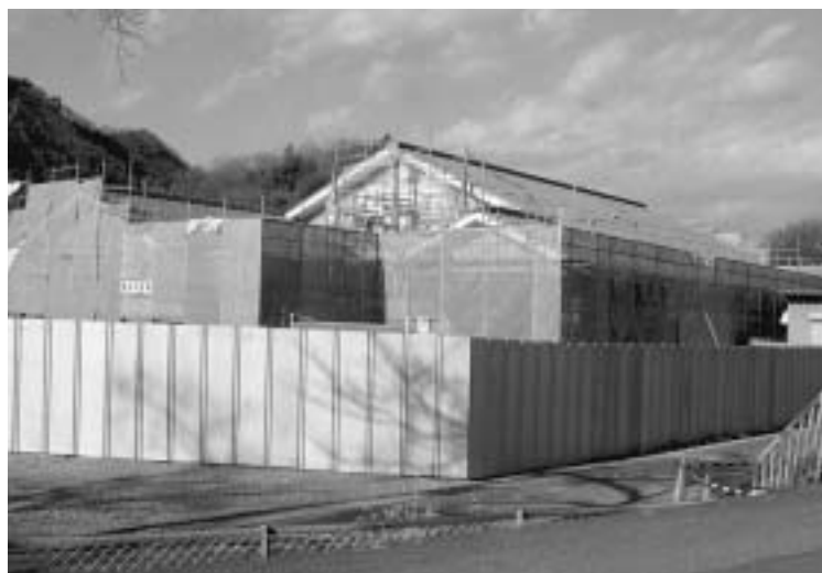
下部地区公民館建築工事状況（下部地区常葉）
