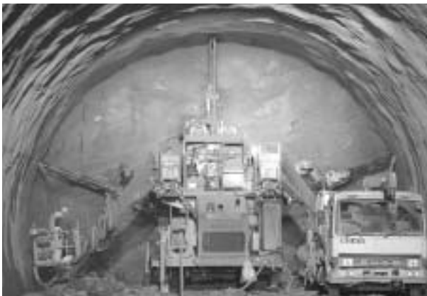
中部横断自動車道「南部町樽峠トンネル北工事」
