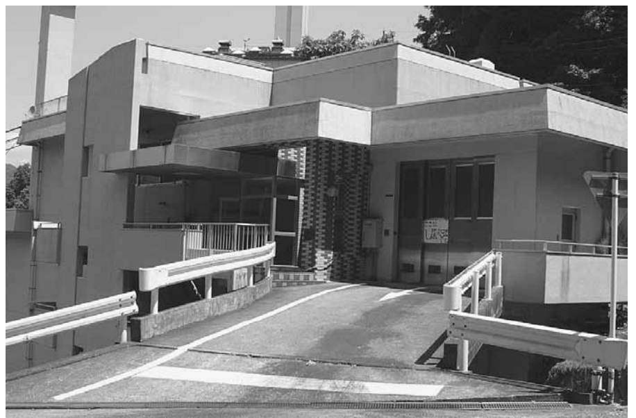
峡南衛生組合「し尿処理施設」
