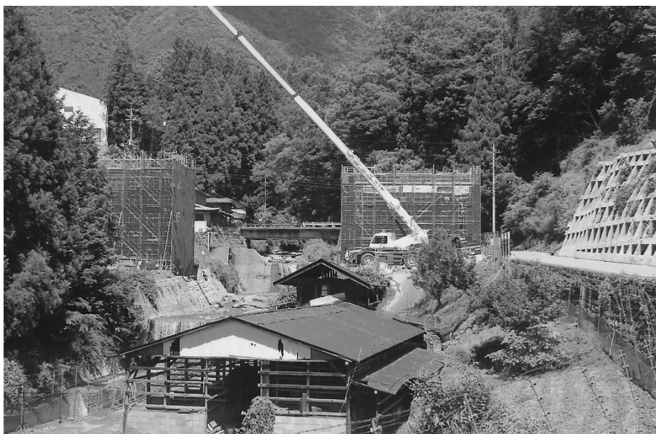
発生土処理場への橋梁建設工事
