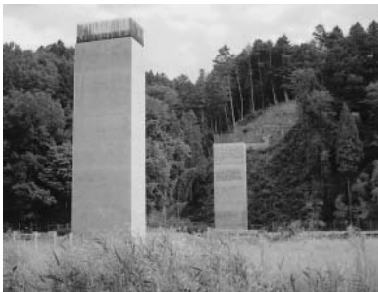
中部横断自動車道田原川橋下部工事（下田原地区）
