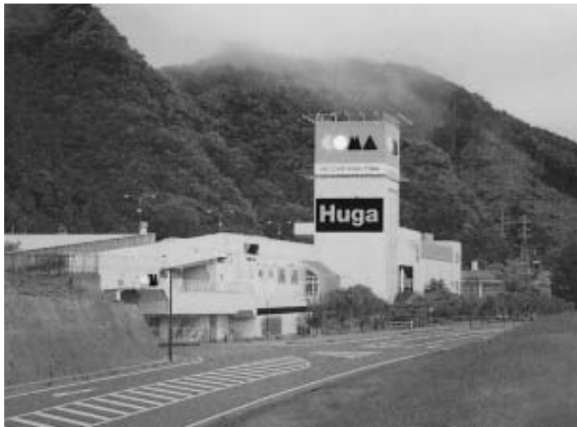
解体予定の旧身延ショッピングセンター「コマ」
