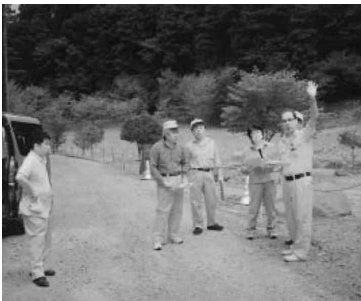
現地調査 身延川上流防砂公園付近河川災害現場
