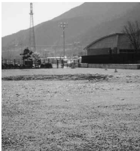
身延地区公民館下山分館建設予定地
