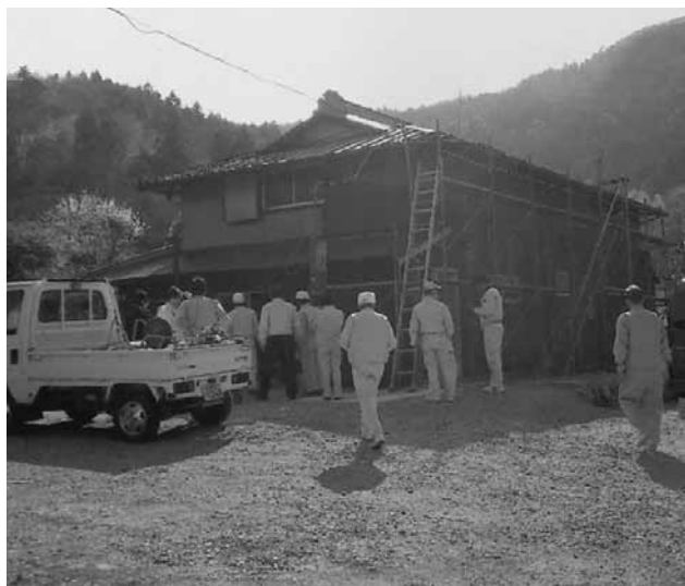
農業体験用簡易宿泊施設改修現場（清子地内）
