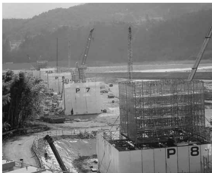
中部横断自動車道橋脚建設現場（大島地内）
