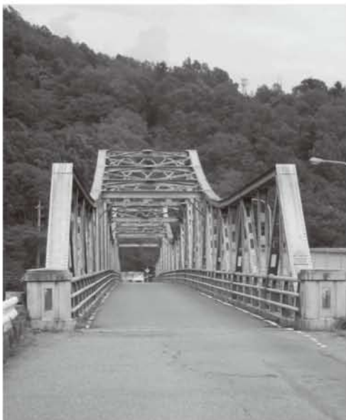
富士川橋(県道割子 - 中富線)
