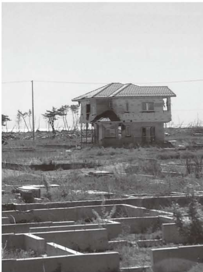
未だに手がつけられていない海岸沿いの被災地
