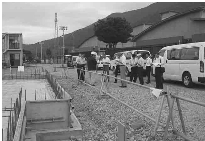
身延地区公民館下山分館建設現場
