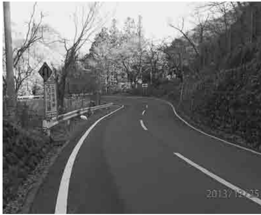
県道市川三郷―身延線 久那土・北側区間 高度差100m 急傾斜・急カーブが多い
