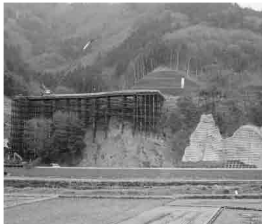
中部横断自動車道「身延インター」工事状況 八木沢地内(撮影;JR身延線・波高島駅ホームより)
