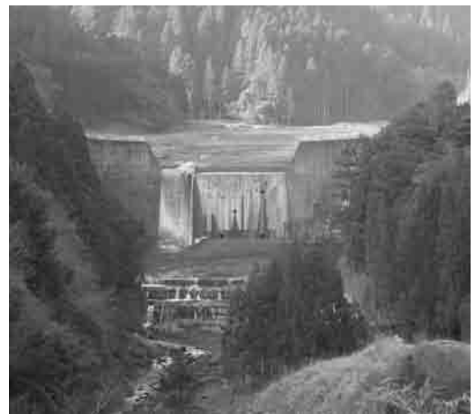
大城川砂防ダム
