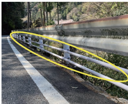
設置された転落防止柵 香雲橋付近
