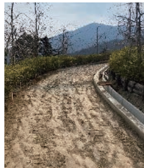
雨水排水整備工事
