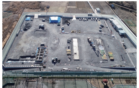
新身延中学校建設状況
