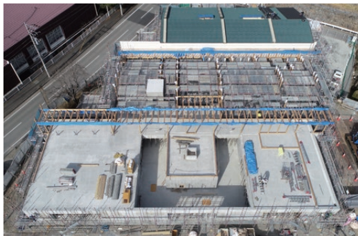
スポーツ健康増進施設建設状況
