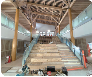
完成間近の校舎内部
