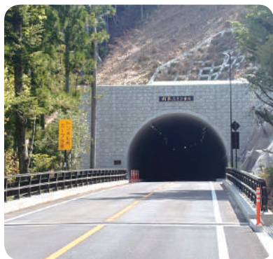
中之倉バイパスのトンネル
