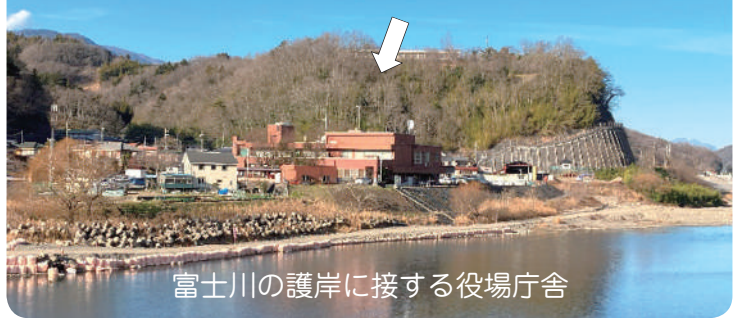
昭和 56 年に建設された役場庁舎
