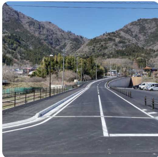
改良された町道本町富山橋線
