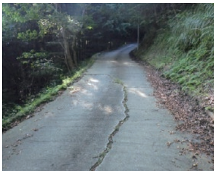
町道古関田ノ上線の状況
