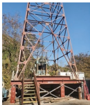
洗浄の工事現場
