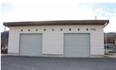
下山防災備蓄倉庫
