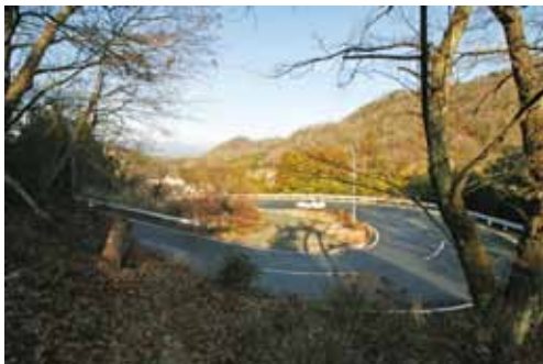
西八代縦貫道
