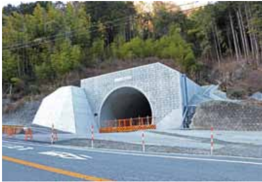
国道300号 灯第一トンネル
