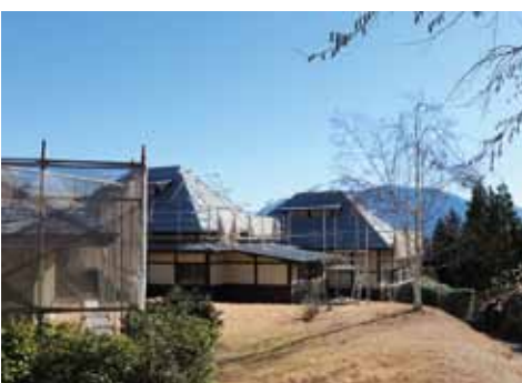
県で行っている修繕工事
