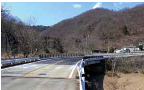
完成間近の西島第一橋
