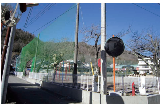
追加された工事場所(身延清稜小学校)
