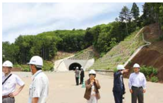
工事中の身延山インターチェンジ
