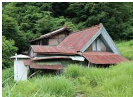
放置された空家
