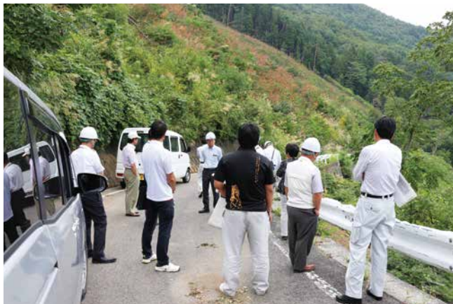
林道折八古関線ガードレール破損場所
