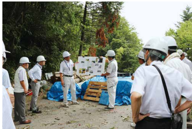
町道静川大須成曙線 道路災害復旧工事
