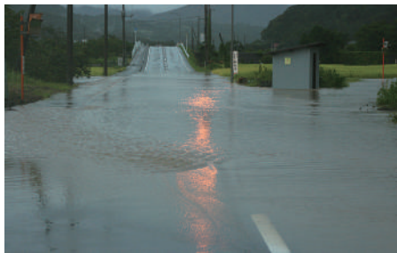
令和元年台風19号水害状況 帯金南口スクールバス停付近
