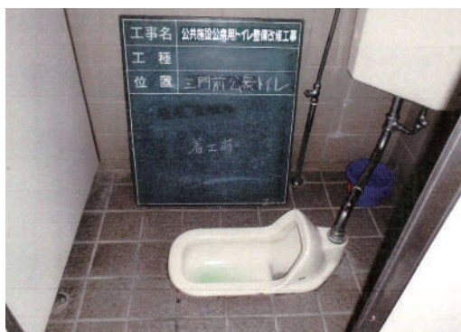
三門トイレ改修工事前
