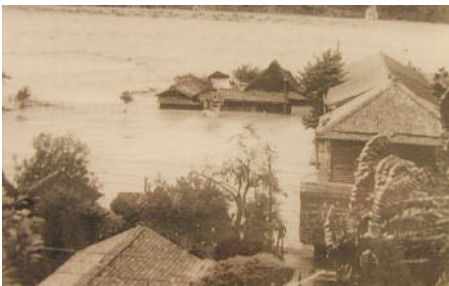
昭和34年台風7号水害状況 旧帯金小学校付近（富士川の氾濫）
