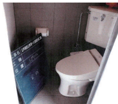
三門トイレ改修工事後
