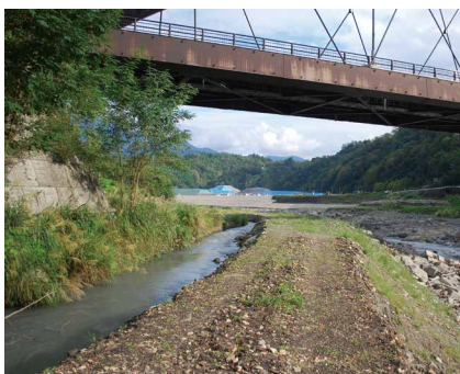
早川橋上流部左岸の水路
