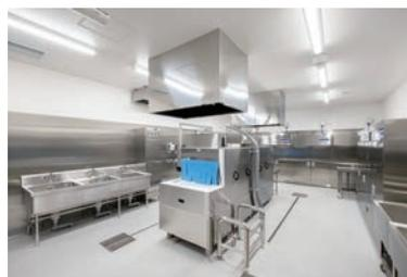
各学校から戻ってきたコンテナや食器を洗浄する部屋です。食缶も洗える食器洗浄機と両面扉の保管庫が設置されており、洗浄後の食缶や食器を保管庫に収め、熱風消毒をします。翌日、隣接する調理室やコンテナ室から取り出して使用できるようになっています。
