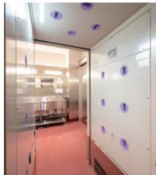
汚染作業区域と非汚染作業区域を隔てるエアシャワーです。強力なエアシャワーを浴びることで、髪の毛や埃を吹き飛ばします。調理室への入室前に必ず通ることが、すべての人に義務付けられています。
