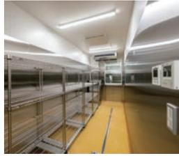
温度管理が行き届いた室内に、米を置く棚と貯米庫（ライスタック）があります。貯米庫は隣室にある洗米機と連携しており、洗米に合わせ指示された分量の米が自動で送られるシステムになっています。
