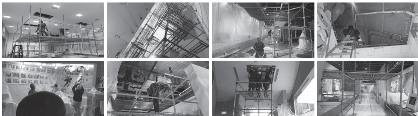
空調設備改修工事のようす
