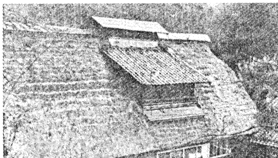
くれぐしの寄棟甲造り（突上げ屋根端）（下部町一色）
