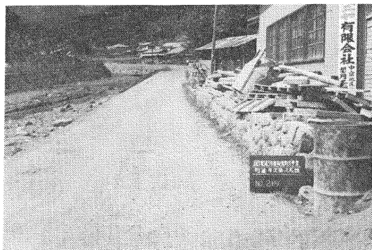
切石―久成線 雁帰付近
