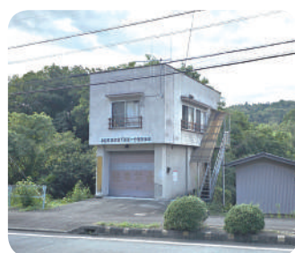
市之瀬消防詰所
