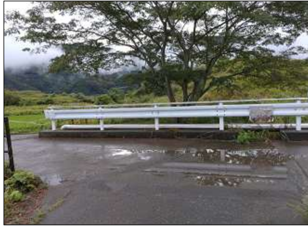
1 下山地区 東団地東側農道
