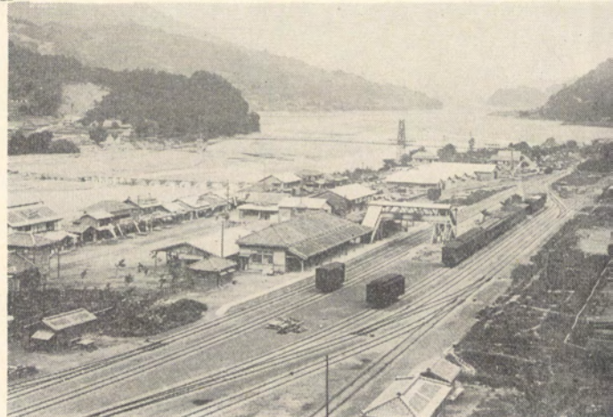
大正11年ごろの身延駅付近（丸山公園より写す） 身延橋は架橋工事中で、手前に仮橋がある。→
