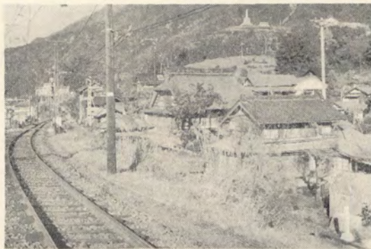
角打南沢下流付近
