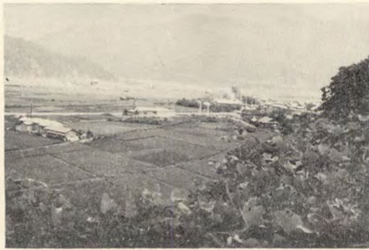
上沢部落より富山橋をのぞむ
